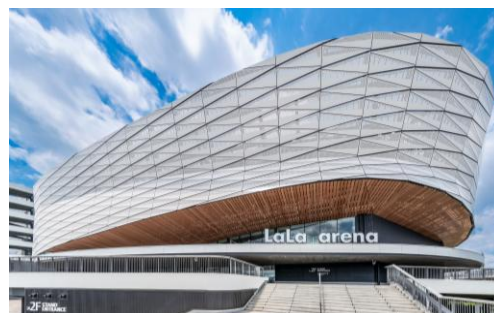
LaLa arena TOKYO-BAY (千葉県船橋市)
